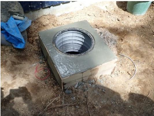
（私の役割）昨年からお世話になっている骨材屋さんで柔らかめの（21-18 0.75mm<sup>3</sup>）材料をダンプに積載して現場に戻ります。固まらないうちに生コンを型枠に流して手で押さえなくてはいけないので、お昼ご飯もそこに作業を急ぎます。生コン打ちは辛い作業です。
