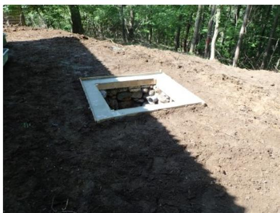
荒船不動付近で40個ほど拾ってきて、石を積み上げ、自然浸透式排水槽の配水管の設置および蓋部分をコンクリートで作成して、その周りの整地します。折本さんは9時ごろに群馬のお寺に移動
